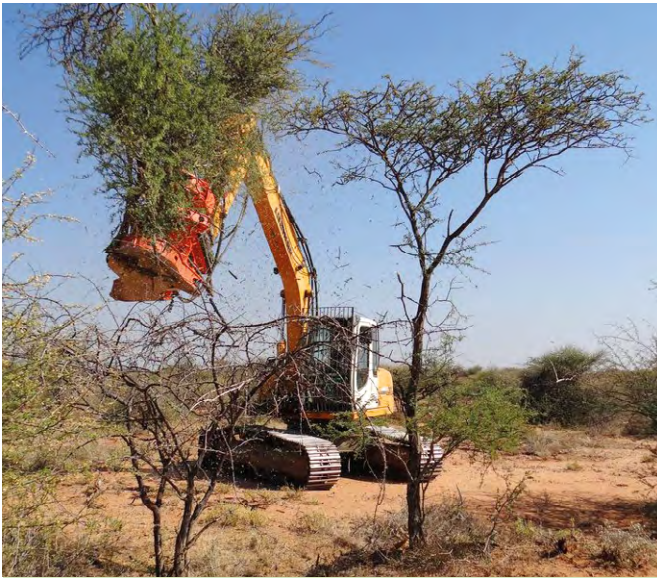
La collecte de brousse mécanisée à l'aide d'un engin spécialisé à cisailles hydraulique (Ohlthaver & List).
