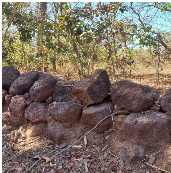
Vue d'en face d'une diguette de Tiarako (ABOU Moussa)
