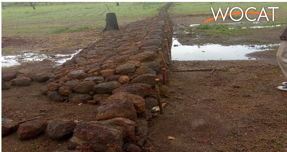
Aperçu d'une diguette filtrante (SOME I. Justine)
