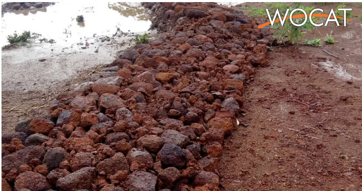
Ouvrage de traitement de ravines réalisé dans le village de Dankari, commune de Koumbia (Province du Tuy) au Burkina Faso (SOME I. Justine)
