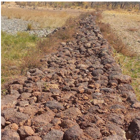
Vue longitudinale d'un traitement de ravines dans le village de Sébédougou dans le dans le micro-bassin versant de Koumbia. (ABOU Moussa)
