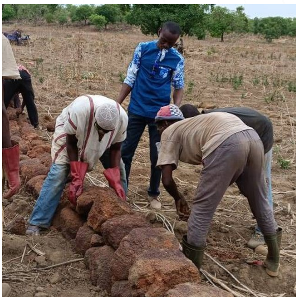
Pose de cordons pierreux par le CVD de Déréguouan dans la commune de Karangasso-Vigué (PALE Joachain)
