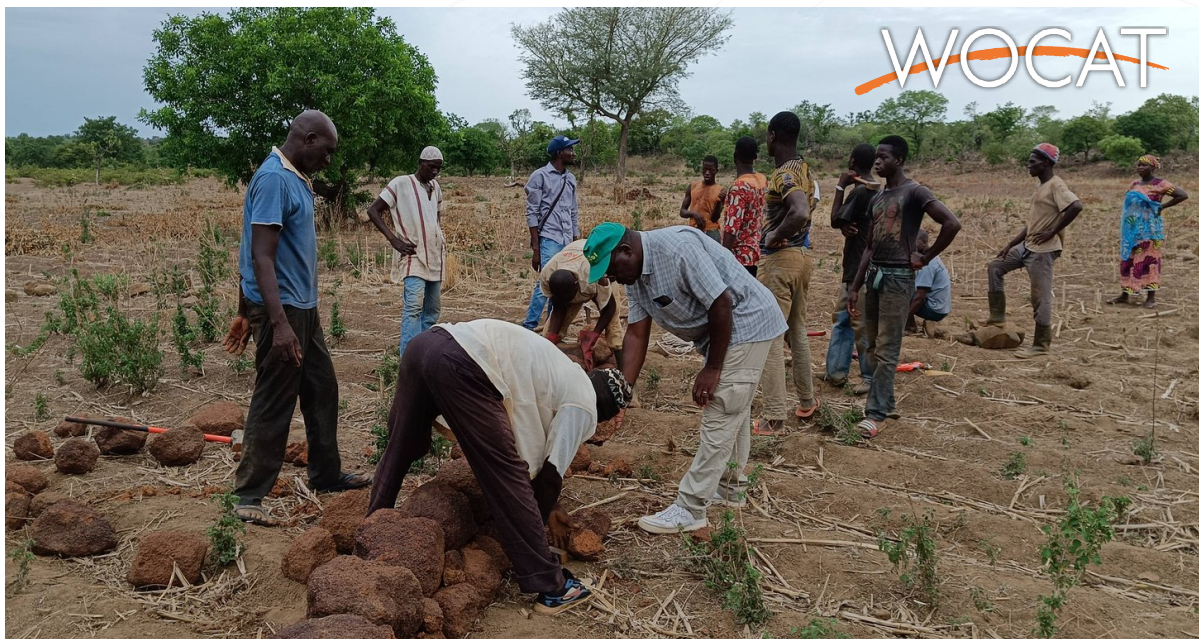
Réalisation de cordons pierreux par le CVD du village de Dérégouan dans la commune de Karangasso-Vugué (PALE Joachain)
