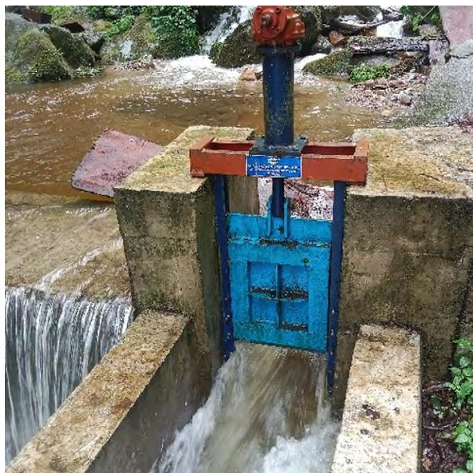
Climate Resilient Irrigation Scheme (sluice gate) (Kuenzang Nima)
