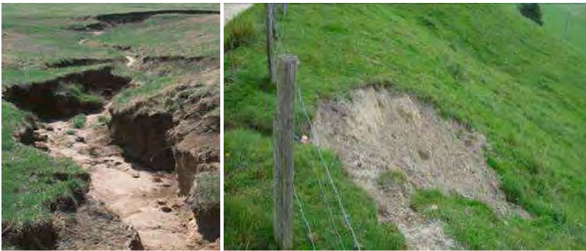
Abbildung 17: Grabenerosion (rechts) mit erheblicher Einschnitttiefe und kleine Hangrutschung (links) in Melchnau (Fotos: links 31.07.2009; http://ag.arizona.edu/watershedsteward/resources/module/Soil/soils-watermgmt-pg4.htm , rechts Urs Grob).
