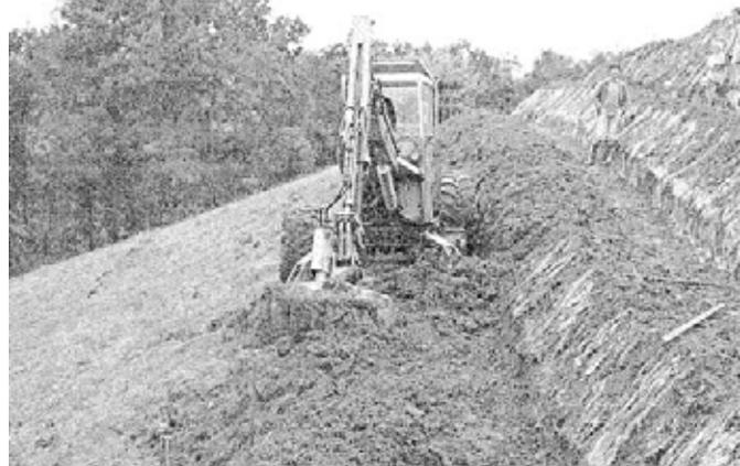
Abbildung 6.10: Erstellung von Kleinterrassen mittels "Menzi-Muck". (Quelle: MURISIER, 1981:79).
