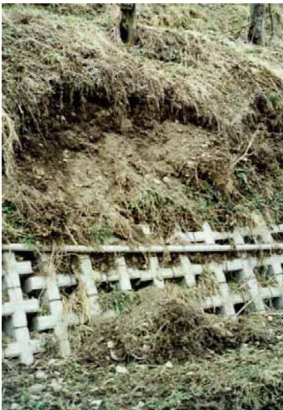
*Abbildung 6.11: Ab und zu bedürfen heikle Stellen in Kleinterrassen einer Reparatur (hier nach dem Winter in einer verstärkten Wendeschlaufe, „Sternenhalde“, Uerikon).*
