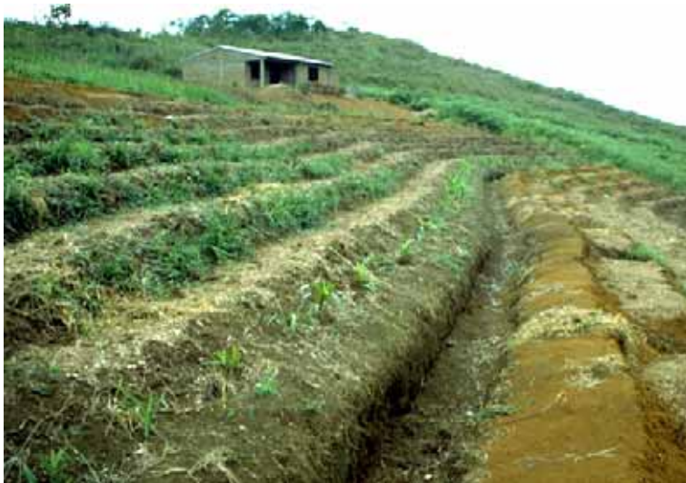
Foto 23: Strukturelle Massnahmen: Mehrzweckgraben mit Schutzwall und Miniterrassen
