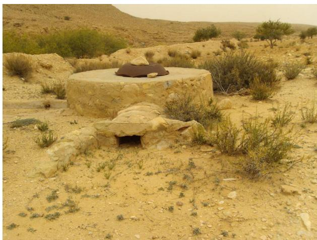
Figure 15: Citerne enterrée de type « majel ». Les écoulements de l'impluvium naturel sont canalisés jusqu'à l'ouverture menant au réservoir.
