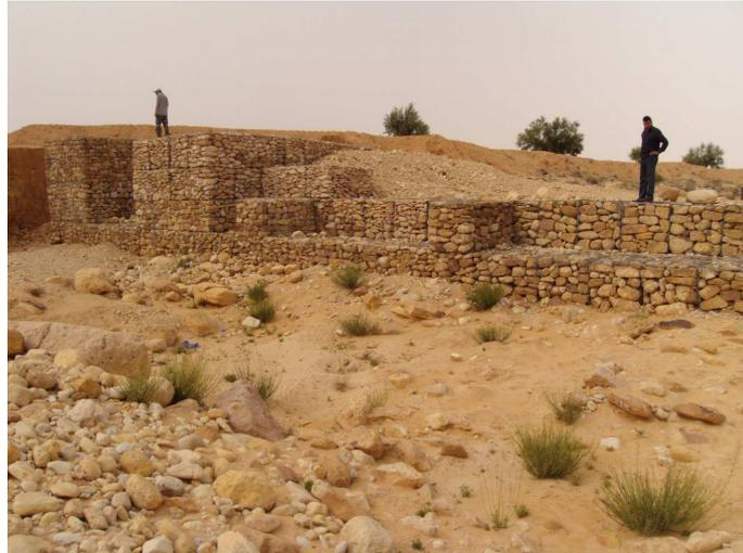
Figure 13: Exemple d'ouvrage en gabion vu depuis son aval.
