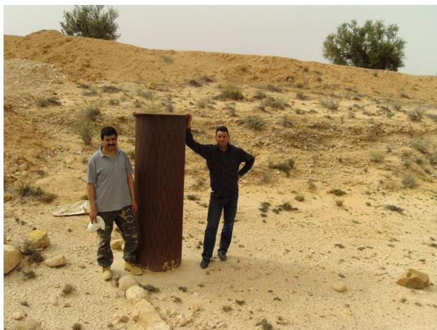
Figure 14: Puits filtrant perforant le sol dans la retenue d'un ouvrage en gabion (non visible).
