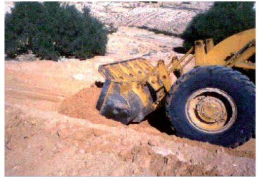
Construction mécanisée d'une digue de *tabia*, Tataouine, Tunisie. (M. Ouessar)
