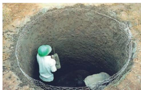
Réservoir souterrain pour la récolte d'eau d'une cour et d'une route au Kenya. Ce réservoir a été équipé d'un piège à sédiments et est utilisé pour stocker l'eau de ruissellement (Nissen-Petersen, 2007).
