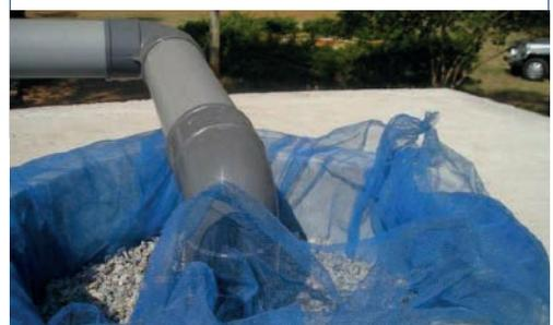
Un filtre en filet, sable et gravier, utilisé au Karnataka, Inde (Rainwater Club, non daté).
