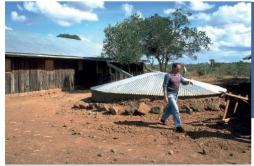
Couvercle en tôle ondulée. (HP. Liniger)
