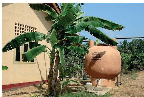
Réservoir en ferrociment au Sri Lanka. (inconnue)
