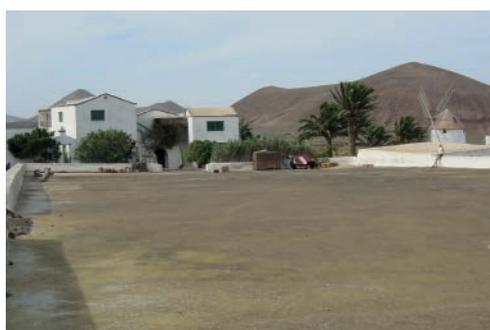
Installation de collecte de l'eau dans une cour ou une surface compactée à Lanzarote, Archipel des Canaries. (W. Critchley)
