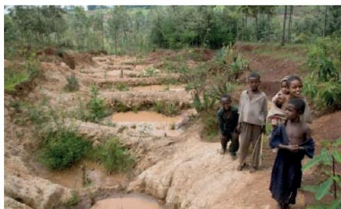
Mares et barrages de retenue pour la réhabilitation de ravines et la recharge des aquifères sur de faibles pentes (HP. Liniger)
