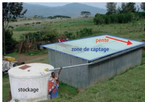
Captage de toit au Kenya, montrant les différents éléments d'un système de ToitsCE. (M. Malesu)
