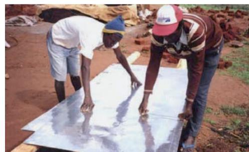
Fabrication de gouttières à section carrée avec de la tôle galvanisée : pliage autour d'une pièce de bois (Nissen-Petersen, 2007).
