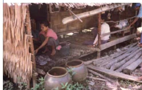
Pour des gouttières plus durables, du bambou est fendu, attaché à quelques morceaux de bois puis fixé selon une pente à la poutre de la maison.
